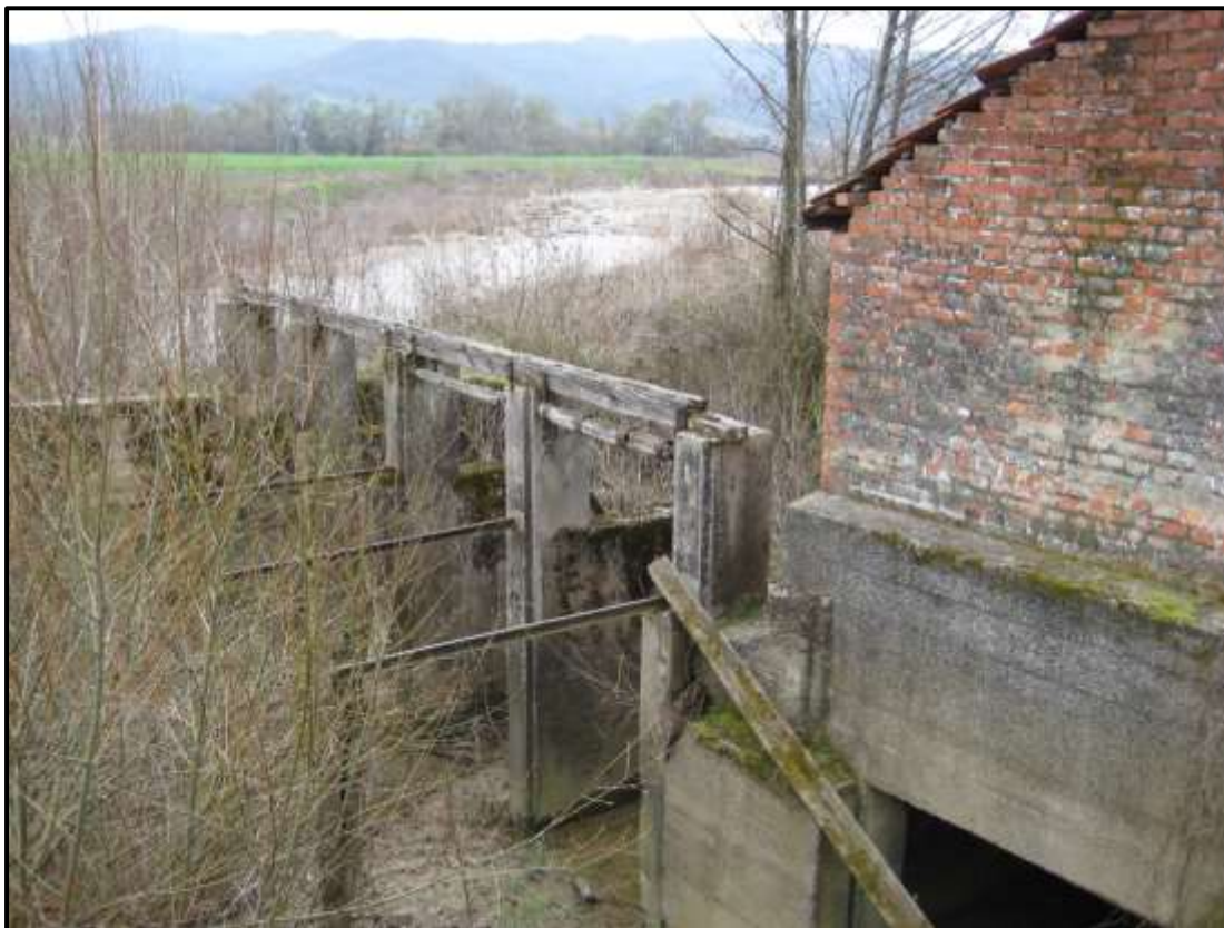
Slika 5 Postojeće stanje - Štajduharov mlin
