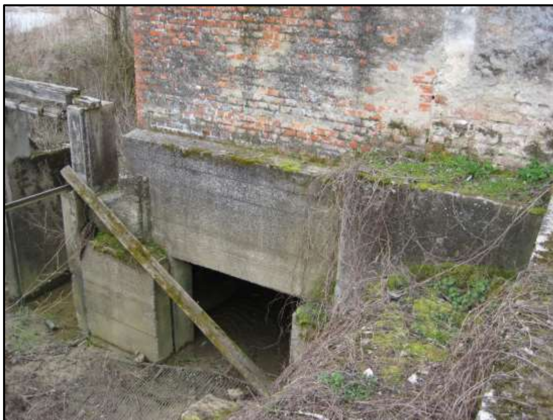
Slika 6 Postojeće stanje – Štajduharov mlin
