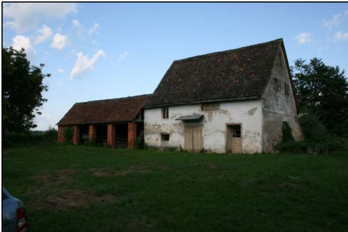
Slika 3 Postojeće stanje - Štajduharov mlin
